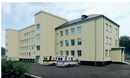
Капитальный ремонт больницы
