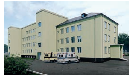
Капитальный ремонт больницы
