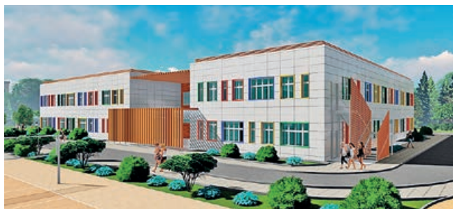
Заказчик: ООО «СР-Групп». Дошкольная образовательная организация (ДОО) на 200 мест по объекту: «Комплексная застройка с объектами социальной и инженерной инфраструктуры по адресу: г. Москва, поселение Рязановское, с. Остафьево, вторая очередь строительства»
