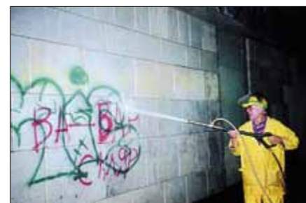
Очистка от граффити
