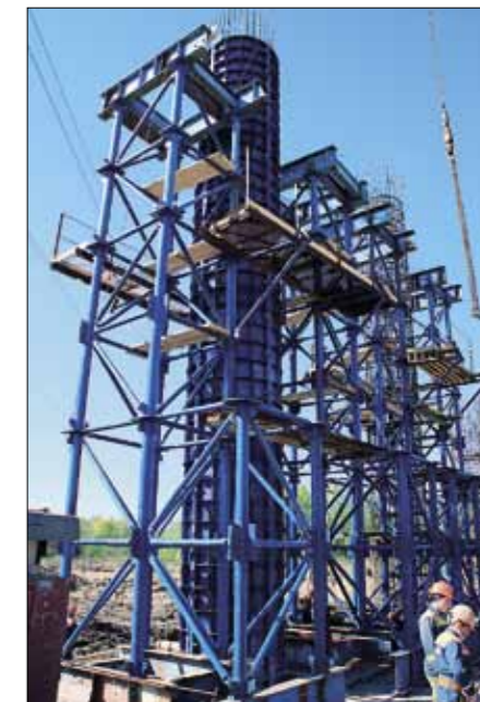
Опалубка колонн «Гамма»
