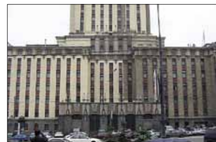
Гостиница «Ленинградская» в процессе очистки
