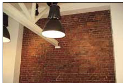
Воссоздание старой кирпичной кладки на оштукатуренной поверхности
