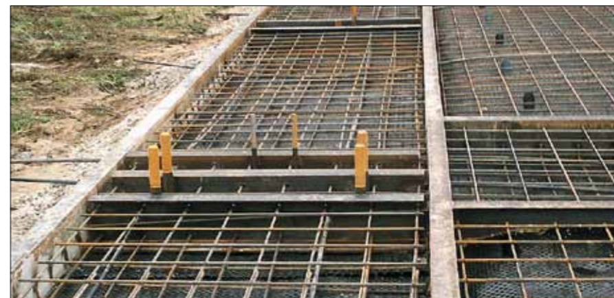
Армирование предварительно-напряженной фундаментной плиты с использованием канатов
