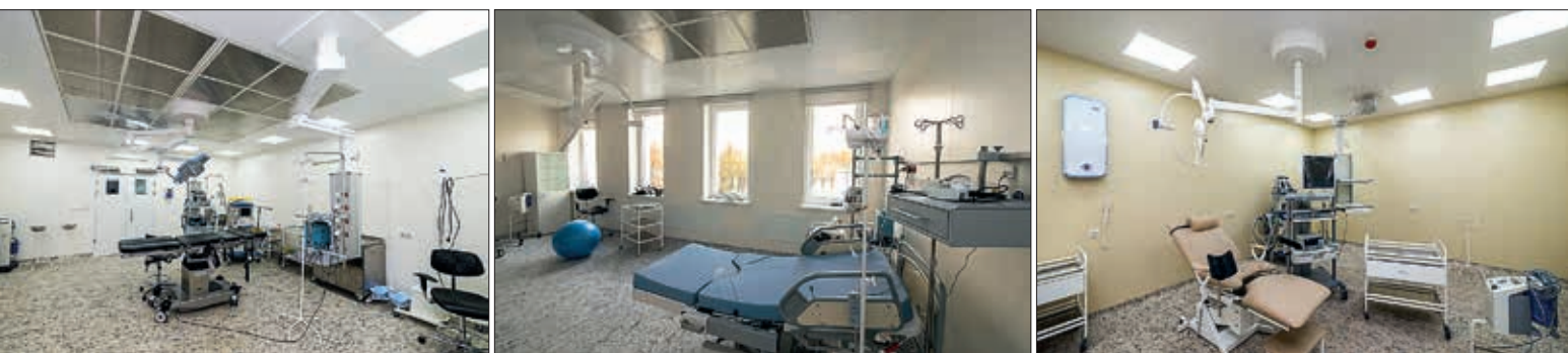
Перинатальный центр в г. Коломна
