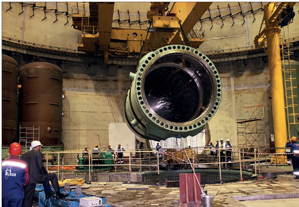
Монтаж корпуса реактора
